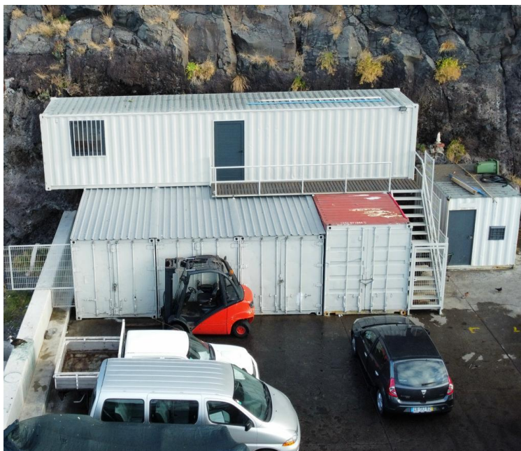
Foto 11: Cais da Ribeira Brava. Instalações de apoio à pesca e alimentação do pescado nas jaulas da piscicultura.
