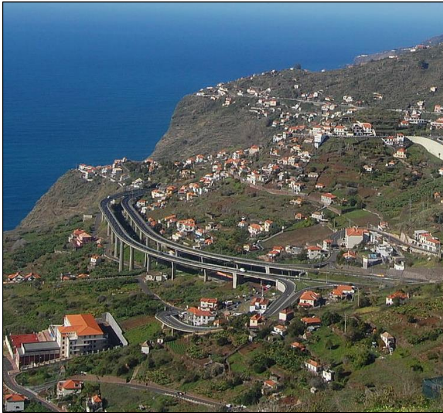
Foto 15: Povoamento disperso existente na área de estudo.
